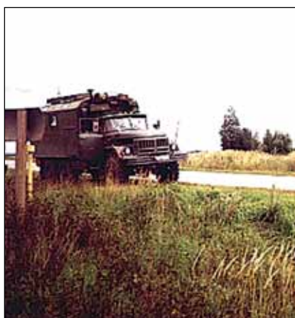
Переход магистрального нефтепровода через автодорогу
