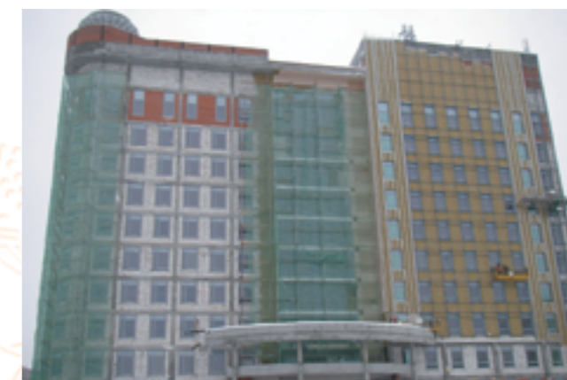
Утепление фасада здания
