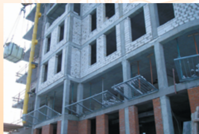
Строительство здания суда. 2009 год
