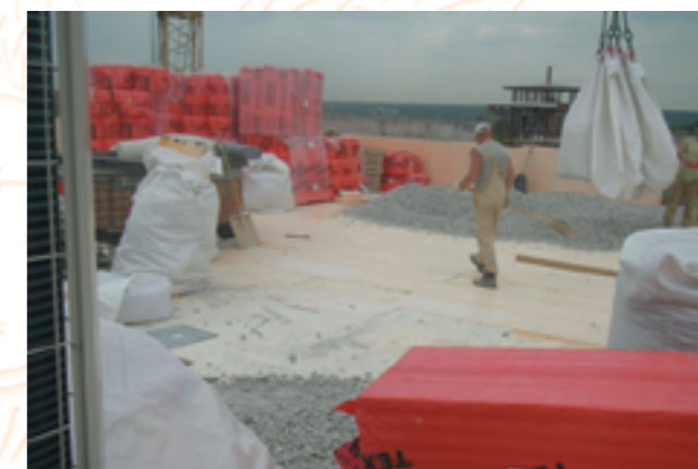
Устройство кровли здания. Май 2009 года
