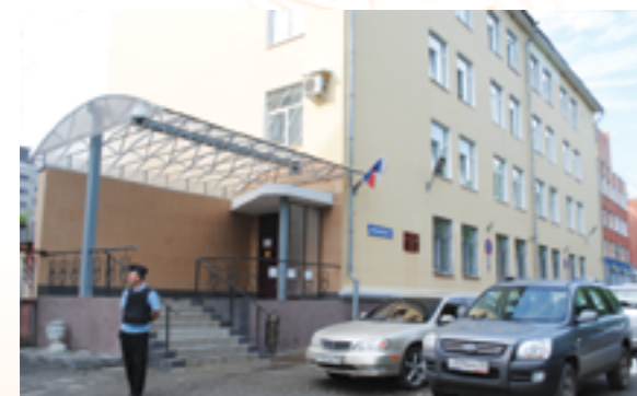
В здании по улице Луначарского, 3 суд находился в весьма стесненных условиях
