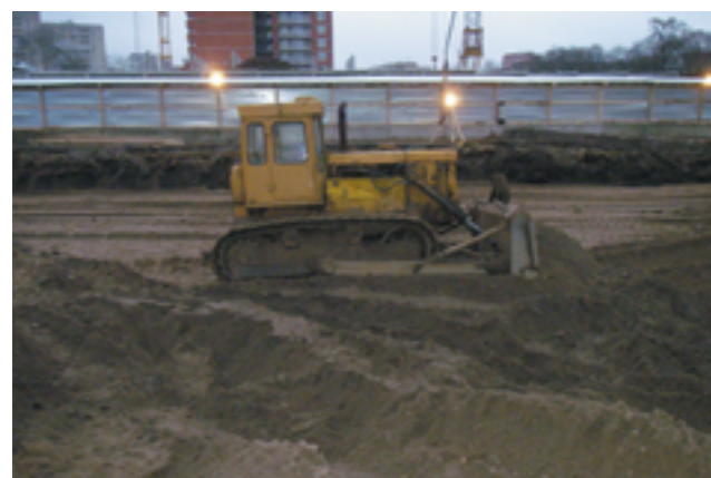
Котлован будущего здания. Ноябрь 2008 года
