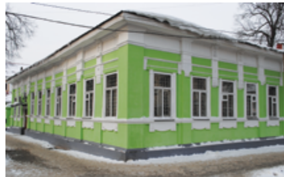
Здание по ул. Большевистской (теперь – Екатерининской), 74, в котором располагался Госарбитраж Пермской области
